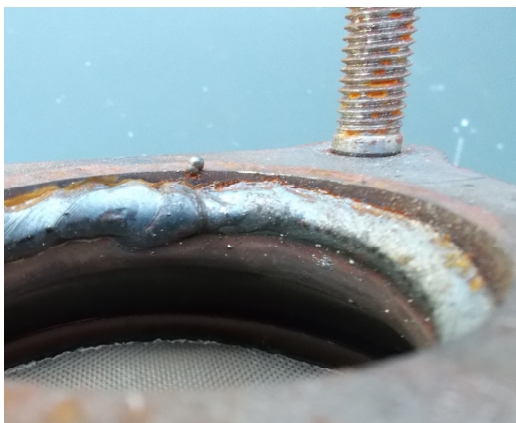
Bild 1: Schweißperlen auf der Flanschfläche Der Flansch kann nur dann dicht montiert werden, wenn zuvor die Schweißperle auf der Flanschfläche weggeflext wird.
